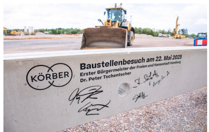
Das signierte Bauteil wird Teil der Dachkonstruktion.
