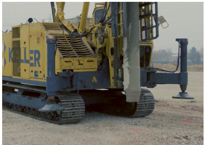
Rüttelstopfmaschine im Einsatz.
