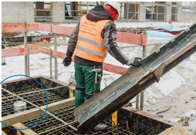
Die Zeitkapsel wird eingebaut
