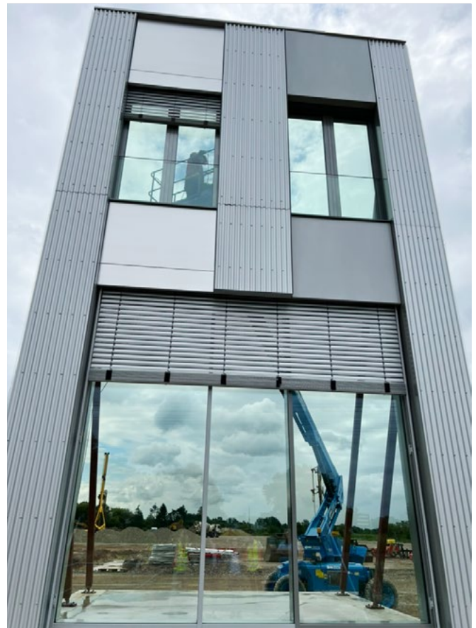
Fassade mit Eloxal-Beschichtung
