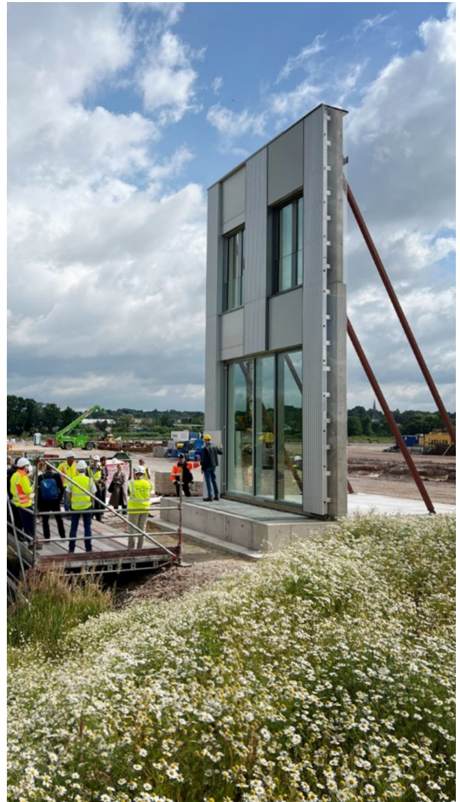
Mock-Up für die Fassade des Körber-Neubaus Hamburg
